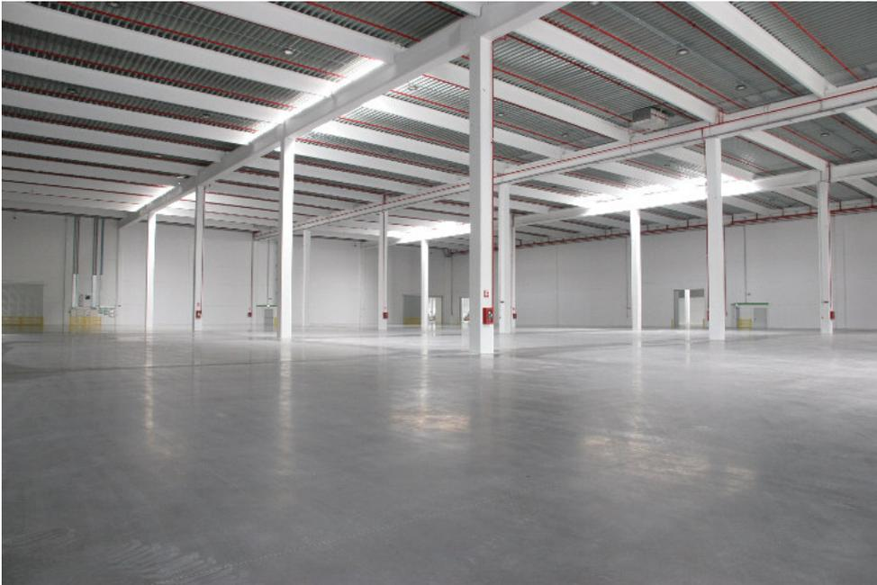
Per quanto riguarda il primo livello a -5,30 m la struttura sarà costituita da pilastri, travi prefabbricate e solaio a doppio T con resistenza al fuoco R120'.
