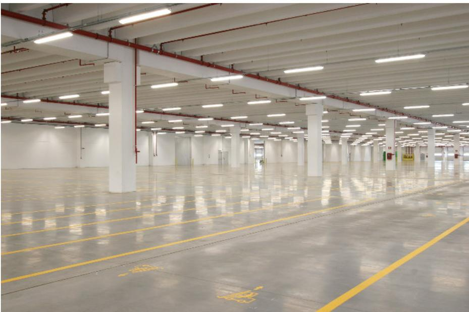
La copertura dell'immobile sarà realizzata con struttura tipo bacacier, costituita da lamiera grecata inferiore in acciaio zincato di altezza 150 mm, barriera al vapore in pvc, coibentazione con materassino imbustato in lana minerale spessore 80 mm e manto impermeabile superiore in lamiera aluzink.
