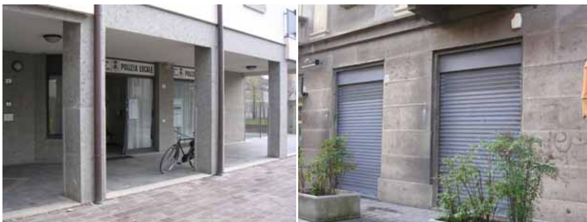
Esempio di servizio posto al piano terra di un edificio (sede polizia locale) ed esercizio dismesso/sfitto
