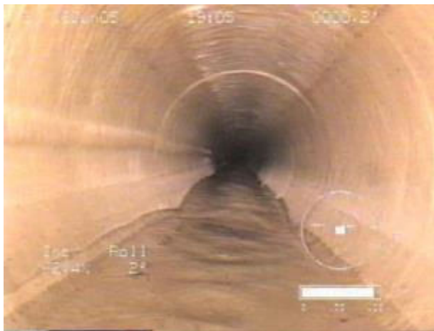
Esempio di apparecchiatura per video ispezioni dei condotti fognari
