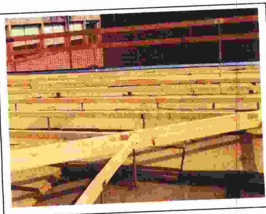
Inoltre il collegamento tra loro delle lastre, di larghezza pari a 550 mm., genera la nascita di un canale di drenaggio e scovo delle acque meteoriche che assicura la completa tenuta all'acqua del manto di copertura, anche in presenza di pendenze molto basse e di eventi temporaleschi di elevata intensità.
