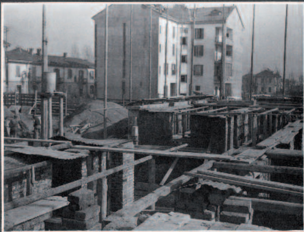
Il palazzo comunale in costruzione
