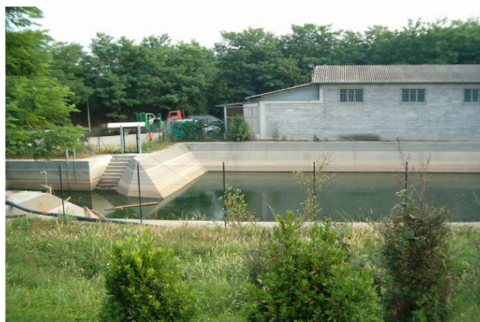
Vasca a cielo aperto di raccolta del percolato
